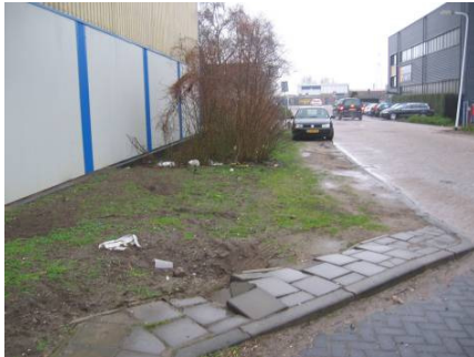
schade gras, zwerfvuil, oneigenlijk gebruik
